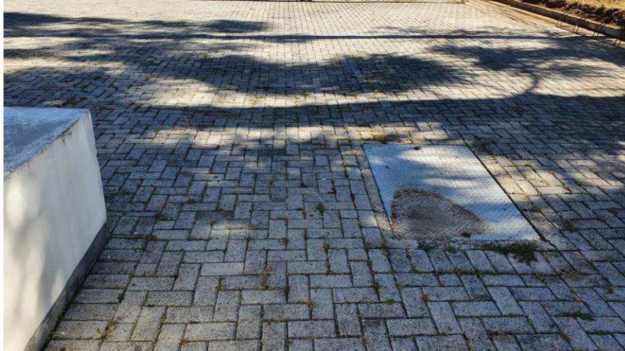
Imagem 3 – Caixa de passagem com tampa metálica na entrada do Fórum
