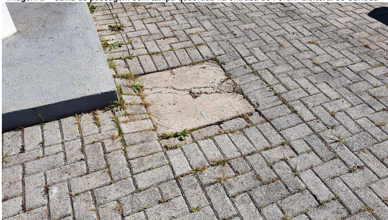
Imagem 2 – Caixa de passagem com tampa quebrada na entrada do Fórum Eleitoral de Curitiba
